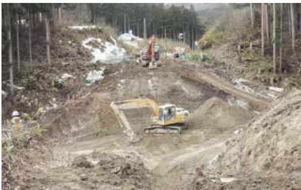
東日本大震災線路崩壊復旧工事
