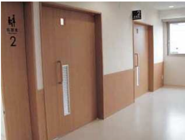
AIDoor を設置した都内の病院。
