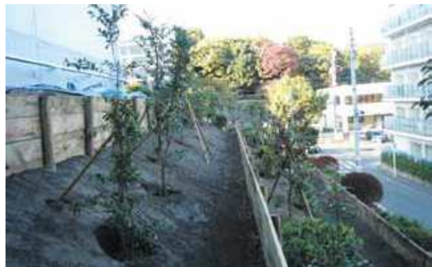
法面災害復旧後施工例
